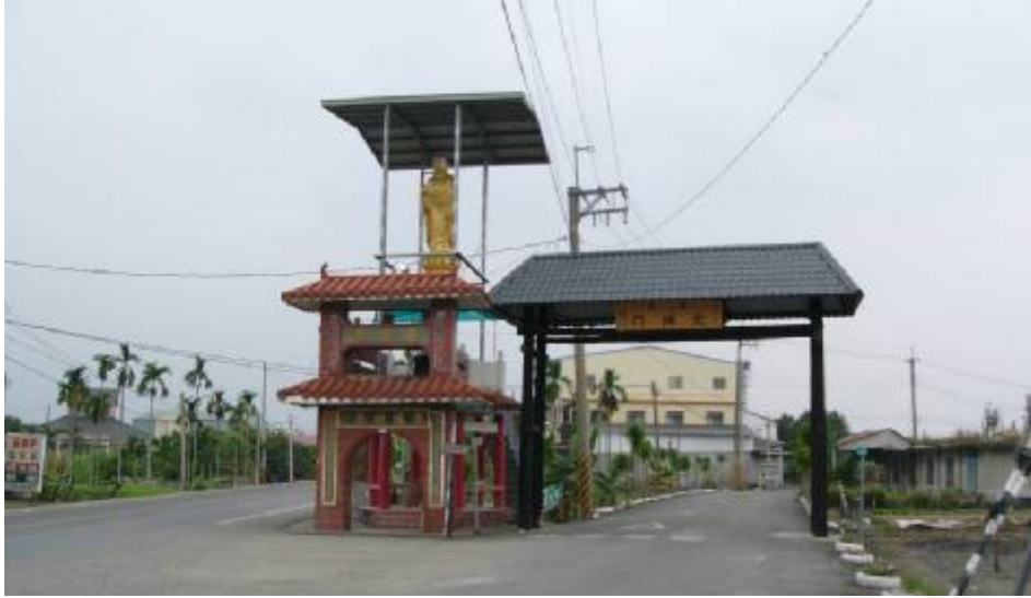
圖二十六 重新修建之東振村北柵門 43
