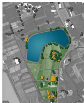
龍樹坑埤全區遠景
