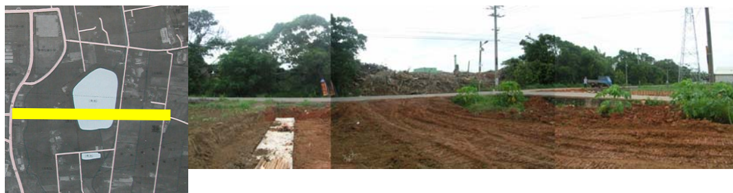
30 米的計畫道路
