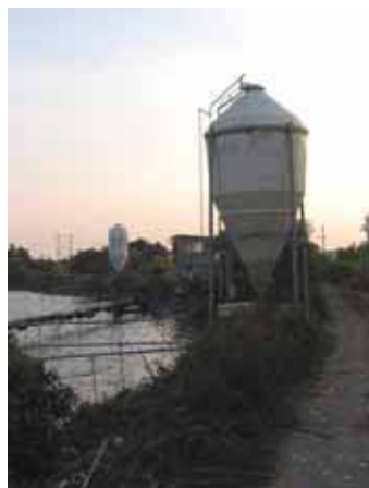
埤邊聳立多座魚飼料塔
