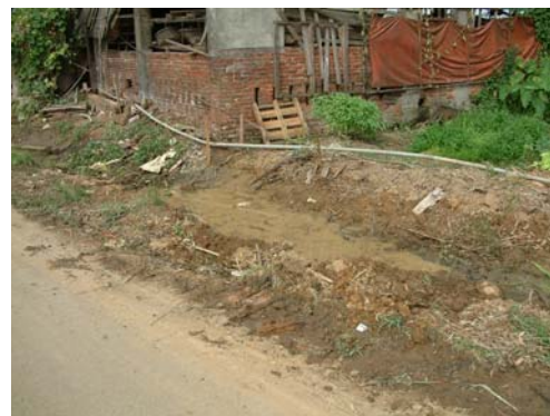
道路兩旁正在進行的排水溝工程
