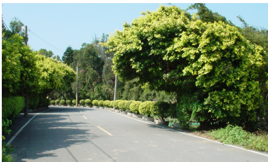
道路規劃整修
