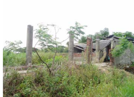
埤塘邊僅有隱蔽的廢棄建築
