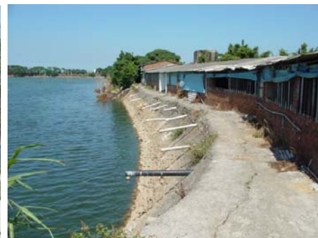
沿堤岸建造的工作間，規模頗大
